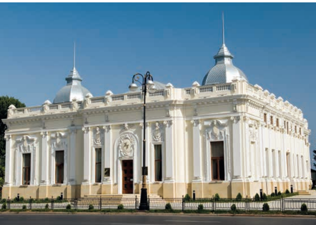
Азербайджанский государственный кукольный театр имени Абдуллы Шаига (ранее кинотеатр «Феномен»). 1912. Баку. Архитектор: И. К. Плошко. В 2007 году были проведены работы по капитальному ремонту и реконструкции здания.
