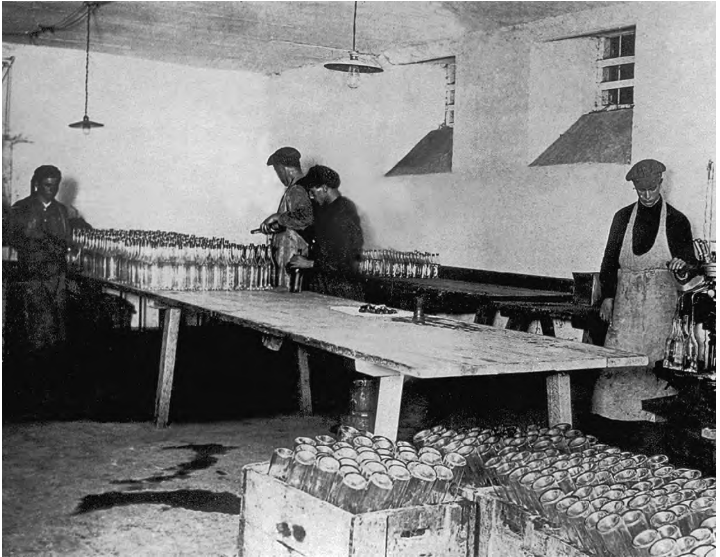
Abfüllanlage der Genossenschaft Konkordija
