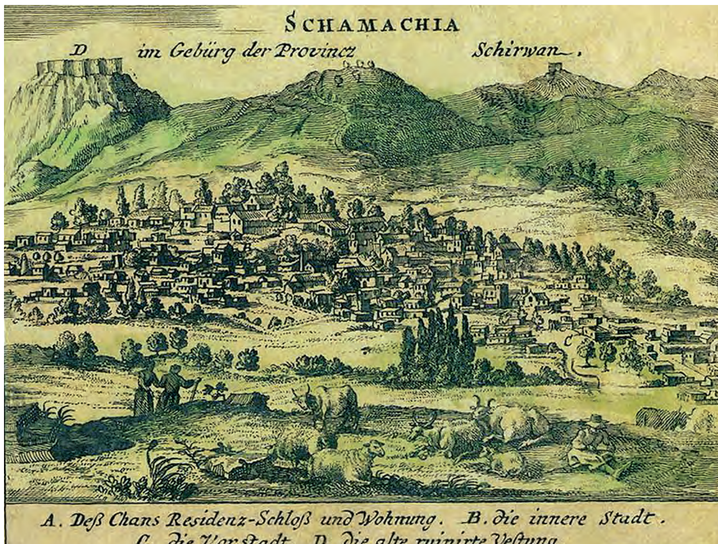
Ansicht von Schamachi – Kaempfer (1683)
