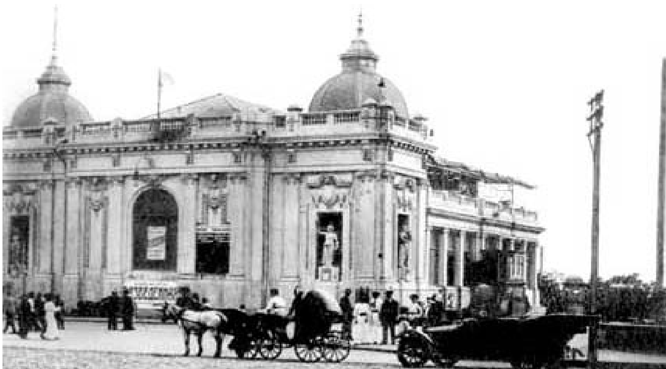
Bakı. «Fenomen» teatr binası (1919)
